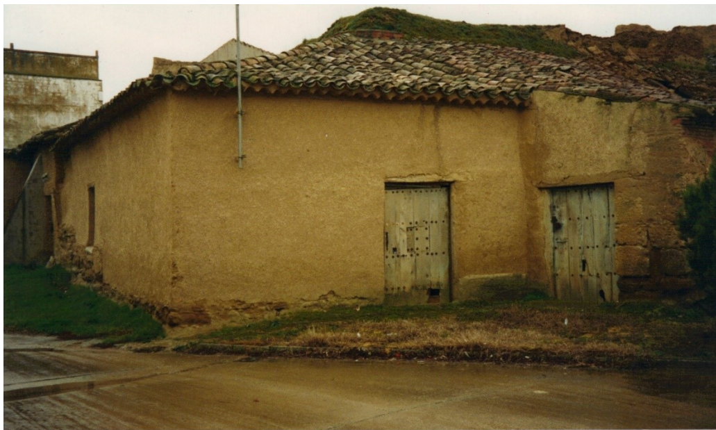
Exterior de la bodega entre la Plaza y la Travesía de la Plaza.
