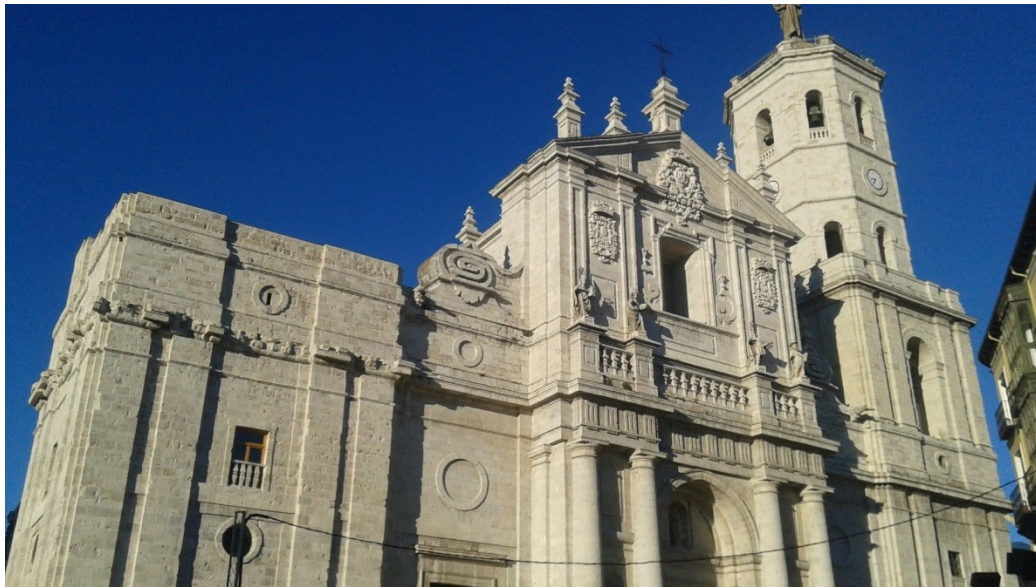
Catedral de Valladolid, construida y mantenida, en parte, gracias a los diezmos pagados por los vecinos de Santa Eufemia.
