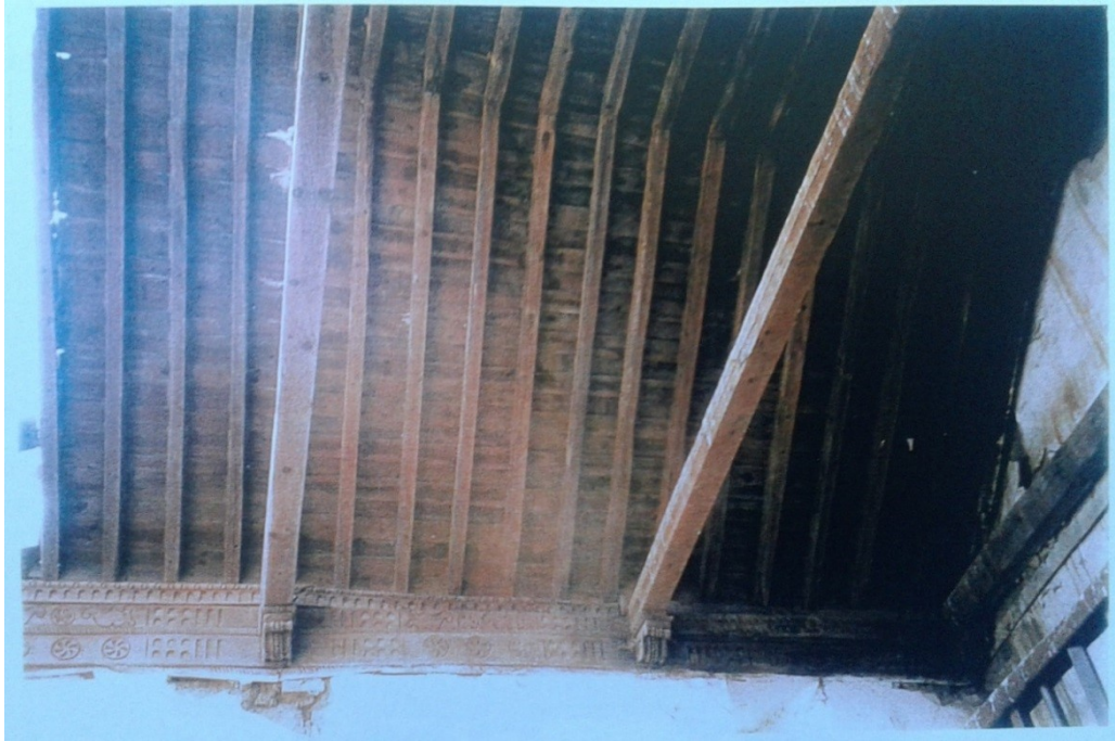
Techumbre de la antigua iglesia de Santa Eufemia. Foto AMSE.
