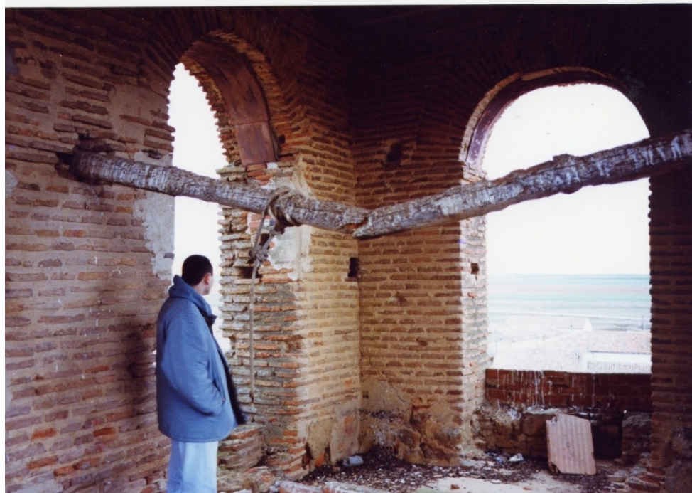
Campanario desprovisto de sus campanas listo para ser derribado, finalmente se salvo de la piqueta, marzo 1999.
